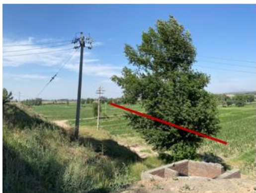
管线穿越阳方口站东北侧农田
