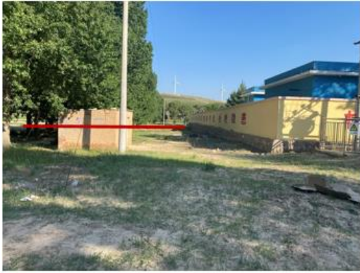
神池站东侧围墙外管线起点
