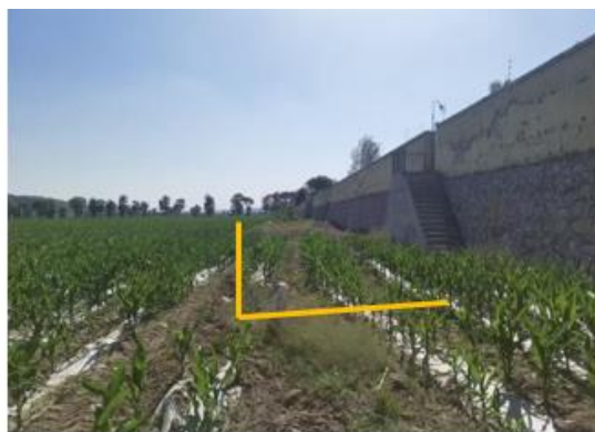
三岔站南侧围墙外管线起点
